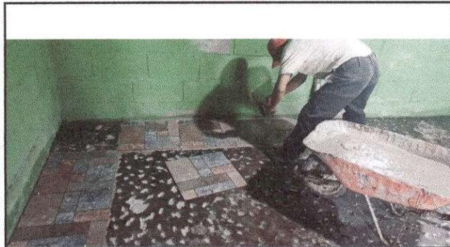
Foto 3: trabajos para la sustitución de piso cerámico en la cocina
